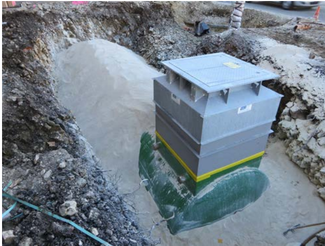
Tank mit LKW - befahrbarem Domschacht Citerne avec trou d'homme carrossable pour camion
